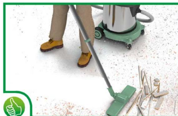
zulässig, daher beim Reinigen saugende Verfahren (z. B. geeignete Industriestaubsauger) verwenden.
